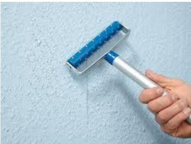
Siempre y cuando se vaya a intervenir sobre un revoco, recubierto o no, con pinturas antiguas, gotelé, texturizadas, etc, el primer proceso a realizar será micro-taladrarlo con **un rodillo de púas**, para detectar revocos y pinturas inconsistentes o en mal estado, así como para que los micro-poros generados ayuden a crear un puente de unión adecuado con la posterior imprimación.
