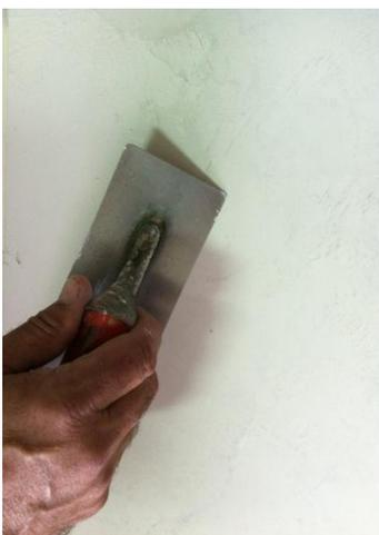
Tras 2 horas como mínimo de secado, se procederá a aplicar una tercera mano de acabado de mortero de Alisado elite. En este caso se trata de aplicar apenas unas micras de espesor con máxima presión. En estas extensiones finales la viscosidad del material ya será más baja, de tal manera que la aplicación resulta mucho más fácil.
